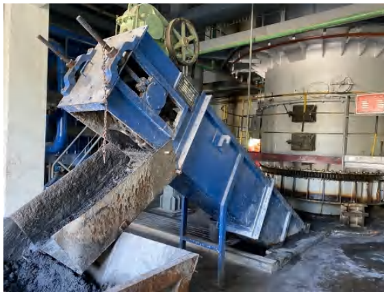
ภาพที่ ๑๐ การนำเถ้าหนักออกจากเตาเผาโดยใช้ระบบสกรู
